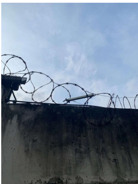
Foto 1 – ponto com haste solta
