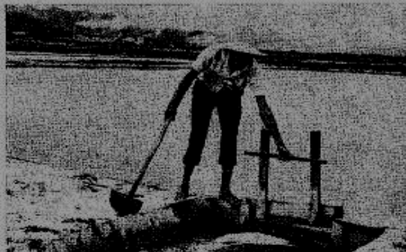
O Sr. Jaime Pereira de Carvalho operando na área dos Concentradores dos Andraes. Aparece abrindo a comporta para distribuir a salmoura, através da canaleta, a outras áreas de evaporação.
