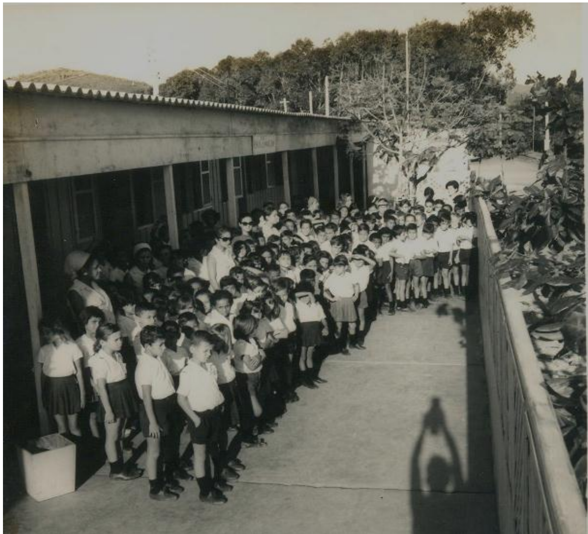
Figura 9 – Fachada da Escola 20 de Julho, prédio de madeira localizado na Vila Industrial e inaugurado em 20 de julho de 1964
