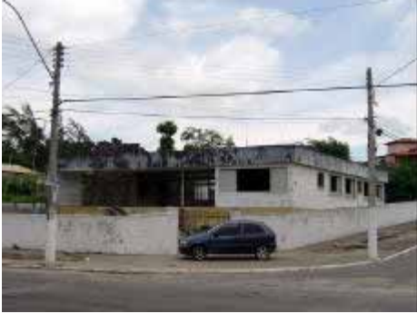
Residência nº525 - Esq. Av. Brasil c/ rua Guatemala. Foto Werther Holzer
