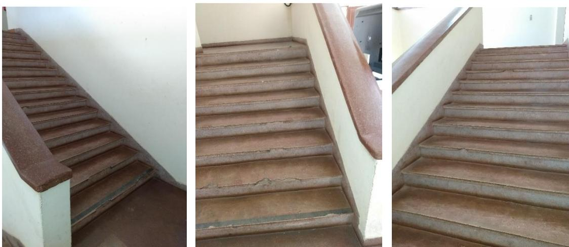
Não existe sinalização tátil nas bordas dos degraus, de cor contrastante, para auxiliar pessoas com baixa visão a identificar cada degrau;
