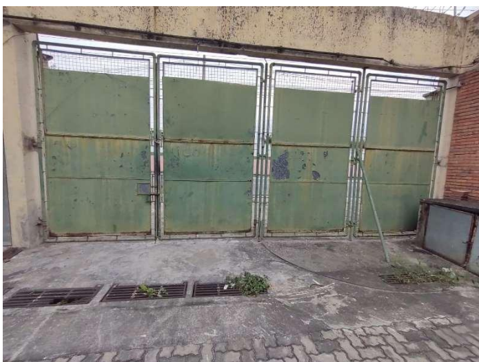
Foto 1 - Portão de carga e descarga
