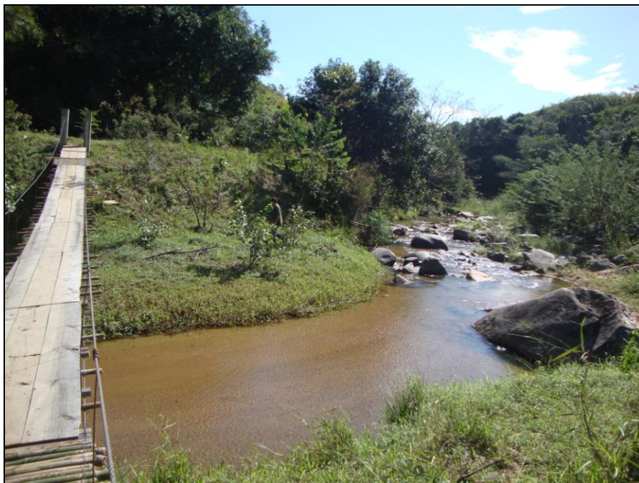
Figura 3.13 Vista parcial do principal rio da região (rio Cacaria), onde foi atribuído APP de 50 m de faixa marginal para a Fazenda Beira Rio, Cacaria, Piraí - RJ.
