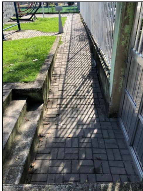
Foto 1: Rampa de acesso localizada no portão principal.
