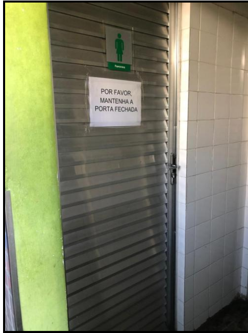
Foto 10: Porta de acesso ao banheiro.
