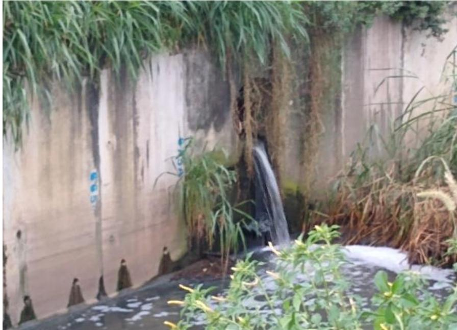
**Figura 14:** saída de esgoto
