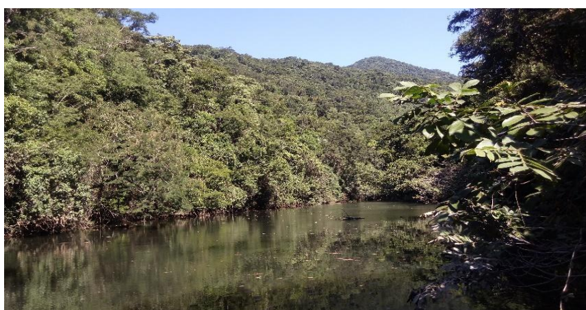
Figura 4 Vista pela Barragem Epaminondas Ramos, situada na entrada do parque. Fonte: Arquivo pessoal (2019)
