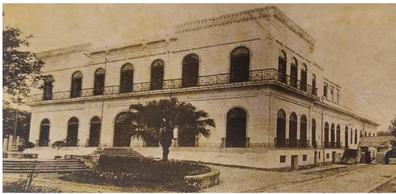
Figura 1: Fachada da Escola Normal de Artes e Ofícios Wenceslau Braz.
