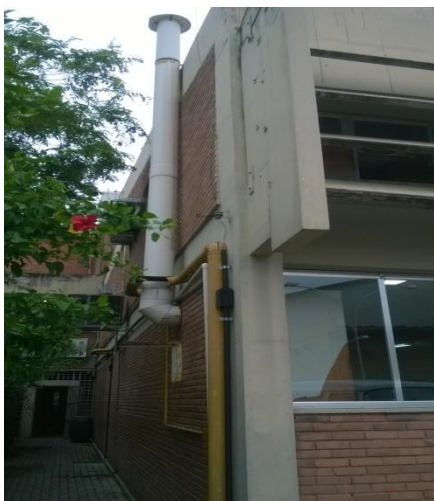
Figura 7: Chaminé da capela do Laboratório de Química Analítica Quantitativa e Águas Residuárias - LSR.
