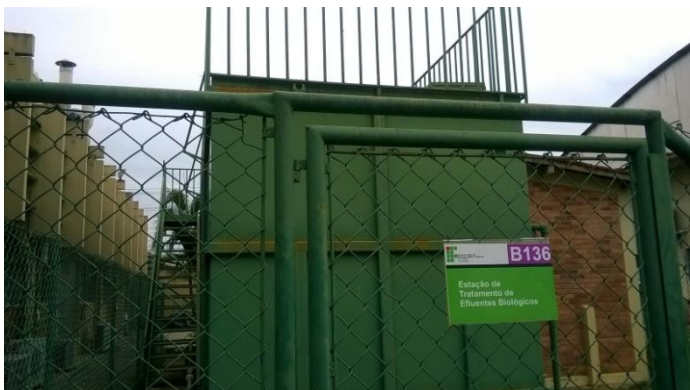
Figura 10: Estação de Tratamento de Efluentes do IFRJ.
