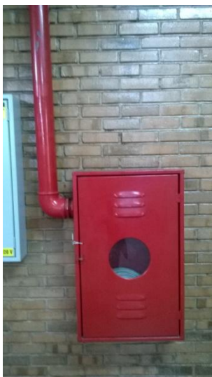
Figura 12: Abrigo de Mangueiras externo ao LSR.
