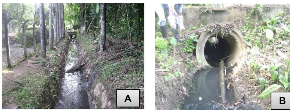
Figura 6.2 A- Córrego Açú lateral ao Viveiro Florestal Luiz Fernando Oliveira. B- Galeria do córrego Açú. Fonte: OZÓRIO 2011.
