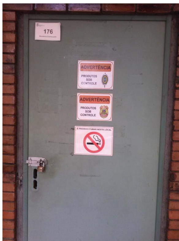
Figura 5.2: Sala de uso restrito para armazenamento de reagentes químicos de classe I (perigosos) controlados no IFRJ, Campus Nilópolis, ano 2014.
