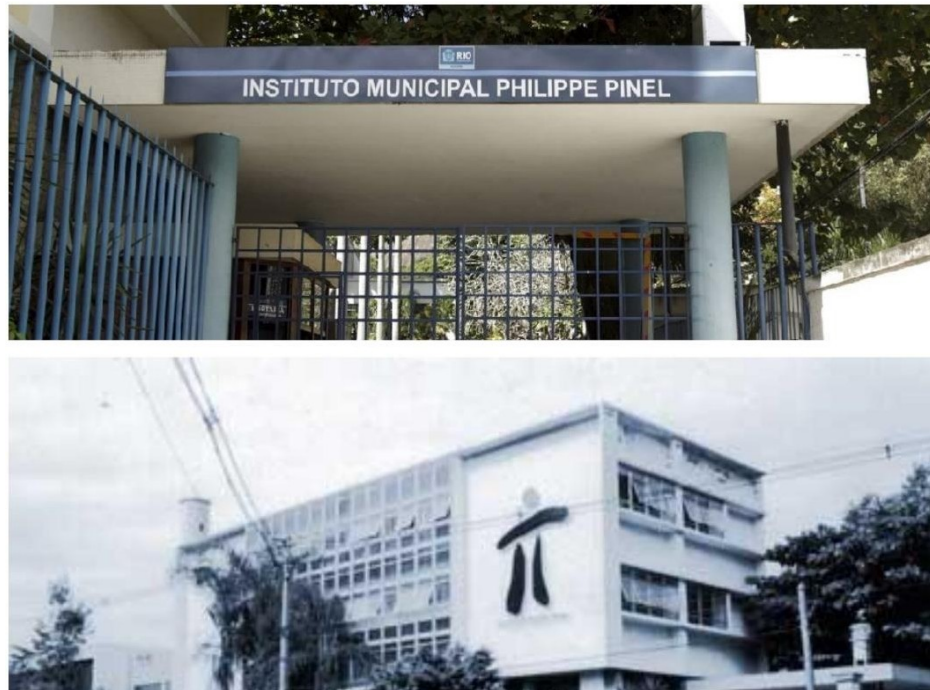
Figura 9: Fotos da fachada do Instituto Municipal Phelippe Pinel. Fonte Google imagens.
