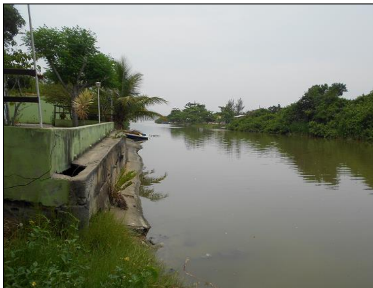
Figura 12: Residência ocupando a faixa marginal de proteção (FMP) no ponto 2 do Canal do Cordeirinho.
