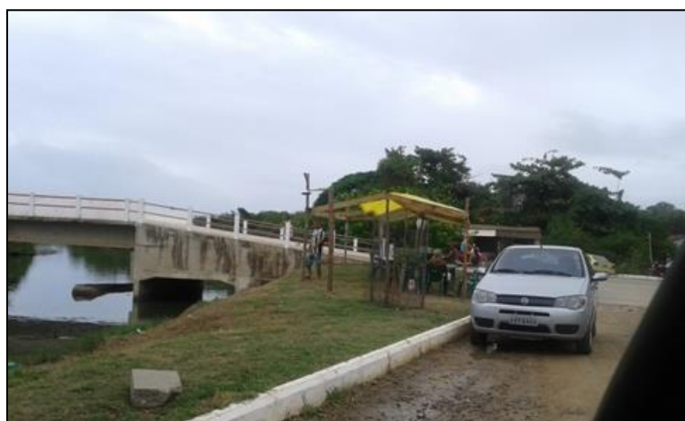
Figura 5: Utilização da faixa marginal de proteção no ponto 1 localizado no Canal de Cordeirinho (18/05/2014).
