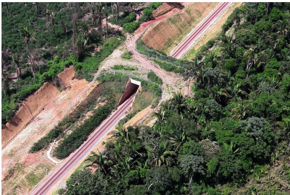
Figura 4.20 Corredor para travessia de fauna em trecho que corta a Floresta Nacional de Carajás/PA. Fonte: O Eco
