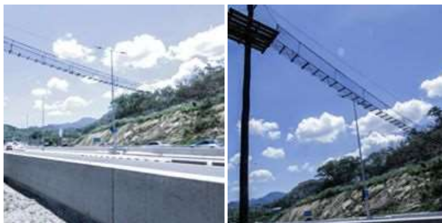
Figura 4.22 e 4.23 Estrutura de Passagem de Fauna na Transolímpica/RJ. Fonte: ViaRio
