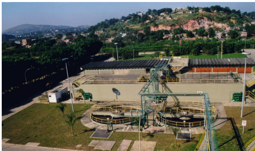
Figura 9. Estação de tratamento de despejos industriais - ETDI (BREIA, 2006).
