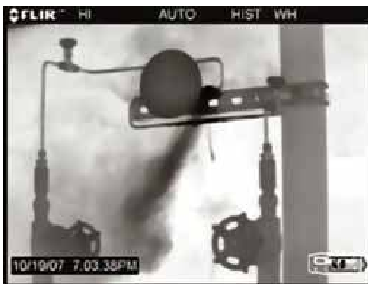
Figura 1.1 Imagem de emissões fugitivas em uma unidade industrial feita com uma câmera de Infra-vermelho
