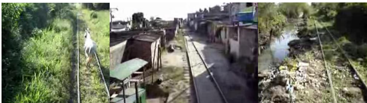
Imagem 3 - Degradação do trecho de São Gonçalo a partir da ferrovia que ligava Niterói a Itaboraí
