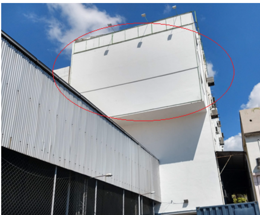
Figura 2- Indicação do local para retirada do painel metálico
