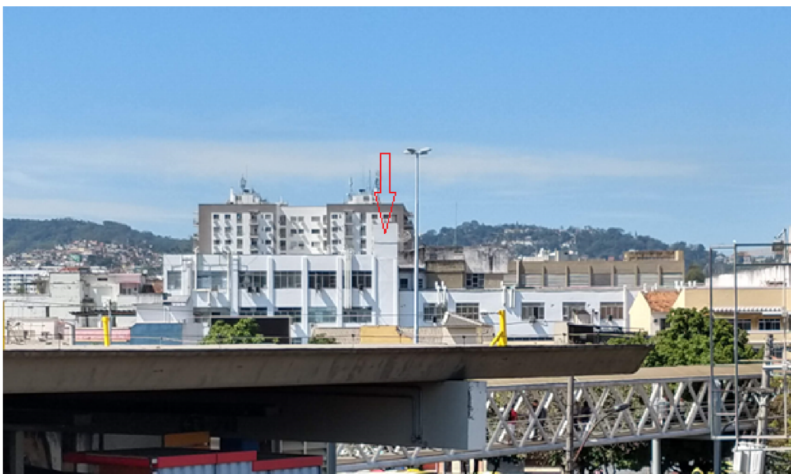
Figura 1-Indicação do local da logomarca da caixa de água
